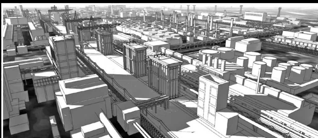
Ryc. 62. Strasse 3 (nazwa zwyczajowa Kammerstrasse). Komory wysokiego ciśnienia (DHD- Bau 331- 339). Z prawej strony zbiorniki oleju ciężkiego. Opracowanie autora.
