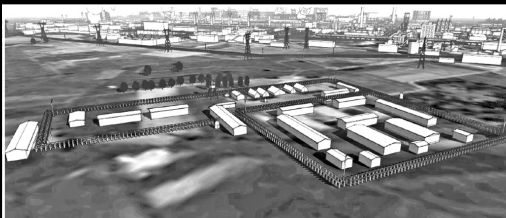
Ryc. 69. Arbeiterziehungslager Hägerwelle (po prawej) wraz z filią KL Stutthof, tzw. „obozem letnim” (z lewej). Opracowanie autora.
