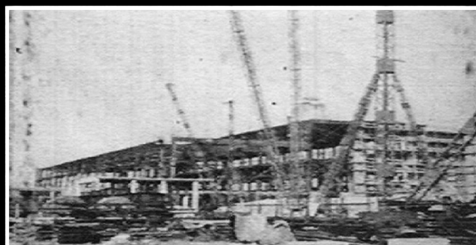
Ryc. 24. Elektrownia w budowie, 1939 r. Źródło: http://www.youtube.com/watch?v=MS6cK2daUI
